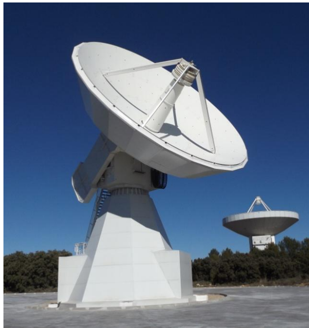
Figura 2. Radiotelescopios en el Observatorio de Yebes (15.2m de diámetro en primer plano y 40m de diámetro al fondo)
